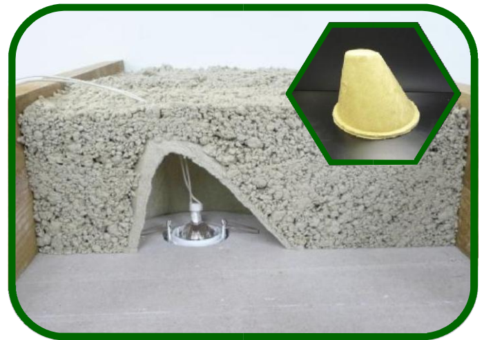
Cône pare-feu pour spot lumineux en plafond, noyé dans l'isolation.
